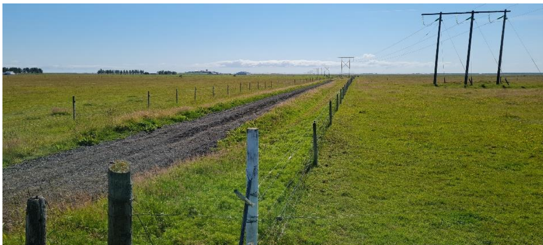
Mynd 4.7 Horft til suðurs með Rimakotslínu 1: Vestari-Garðsauki, reiðstígur. Mynd: EFLA, 2021.
