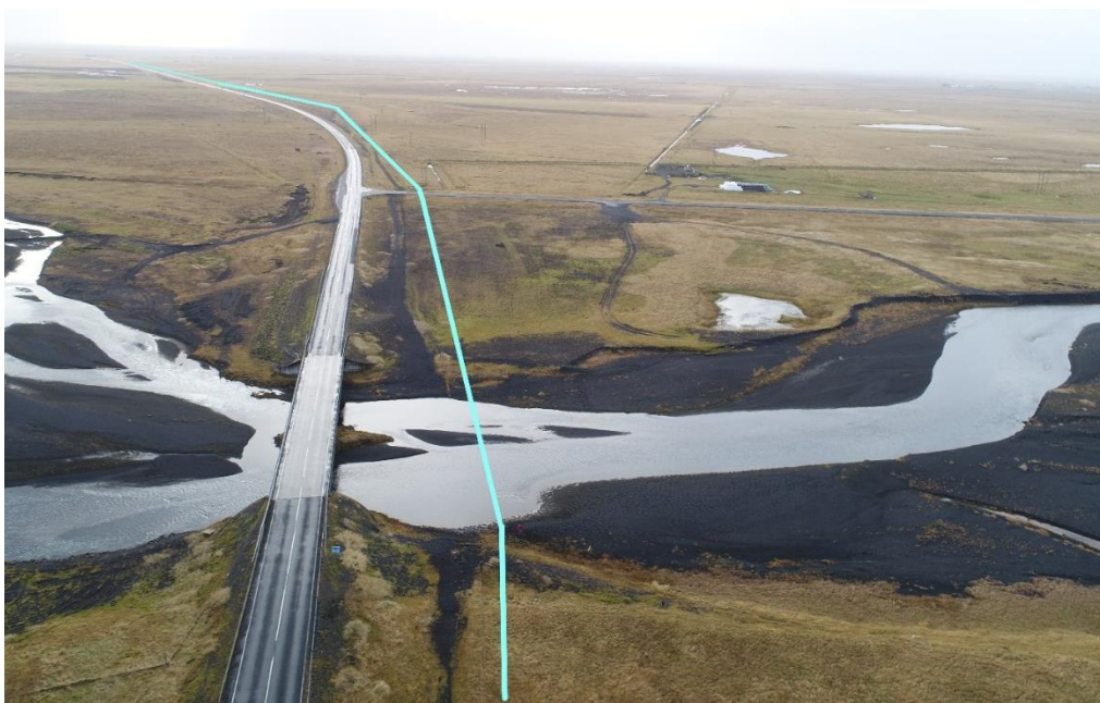
Mynd 3.12 Lega strengsins (blámerktur) yfir Þvera um árbotninn og meðfram Suðurlandsvegi. Horft til suðurs.
