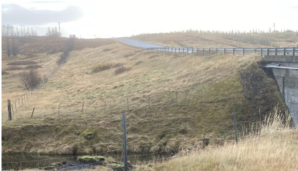
Mynd 3.17 Yfirborð strengleiðar Hellulínu 2 (66 kV) algróið 6 árum eftir lagningu, árið 2021. Mynd: Landsnet.
