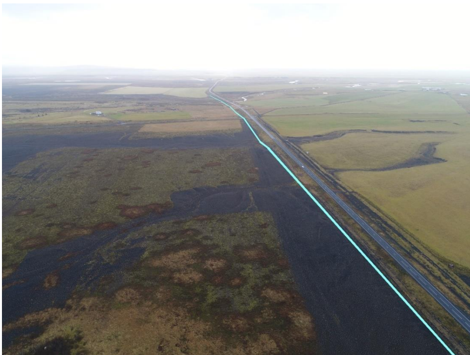
Mynd 3.10 Lega strengsins (blámerktur) meðfram Suðurlandsvegi. Í fjarska má sjá Strandarsíki. Horft til suðausturs.
