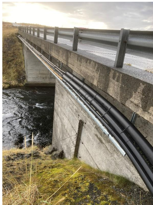
Mynd 3.3 Dæmi um hvernig jarðstrengir eru lagðir í rör í strengstiga undir brúarvængjum þar sem þvera þarf stærri ár og læki.
