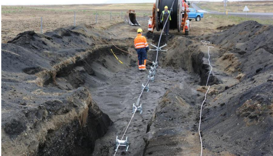
Mynd 3.16 Frá lagningu Hellulínu 2 (66 kV), 2015. Mynd: Landsnet.
